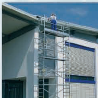
Rollrüstung im Einsatz
